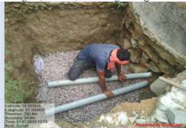
कुआ रिचार्ज के लिये फिल्टर निर्माण
