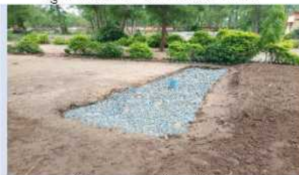
ईजेक्शन युक्त ट्रेन्च निर्माण
